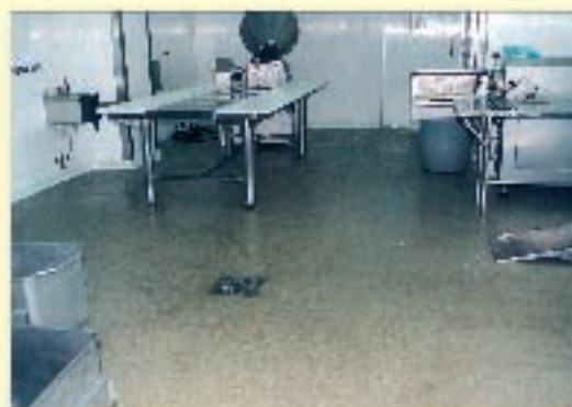
Pavimento in resina per se umificio.
